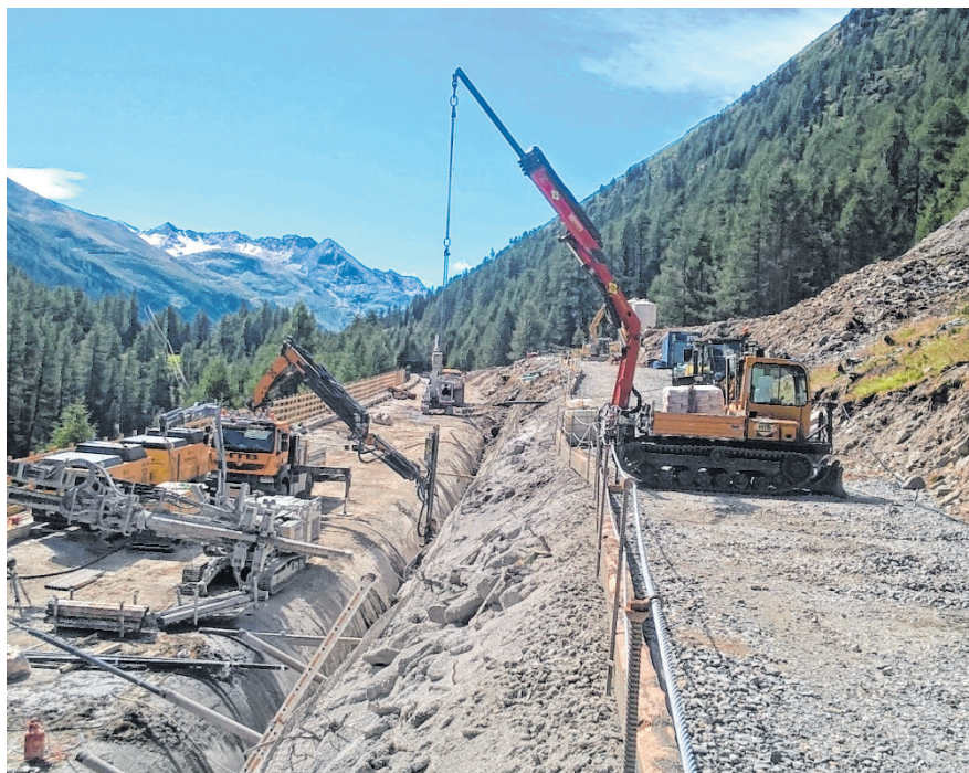
Die Leckgalerie zwischen Sölden und Obergurgl war von einer Mure betroffen und musste verstärkt werden (l.). Die Wasserversorgung Tirols mit Großquellen (r. o.) ist ebenso Thema im Tagungsband wie die Bohrungen der Uni Innsbruck im Fernsteinsee (r. u.).
